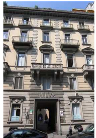
L'ingresso della sede ACSE di Torino
